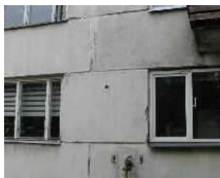
4.2.7.att. Saduršuvju izdrupumi aiztaisīti.
