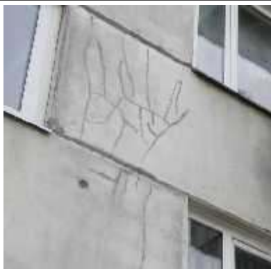
4.2.8.att. Mikroplaisas panela virsmā.
