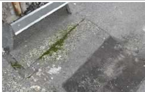
4.8.4.att. Mitruma plankumi un sūnas uz jumta seguma.
