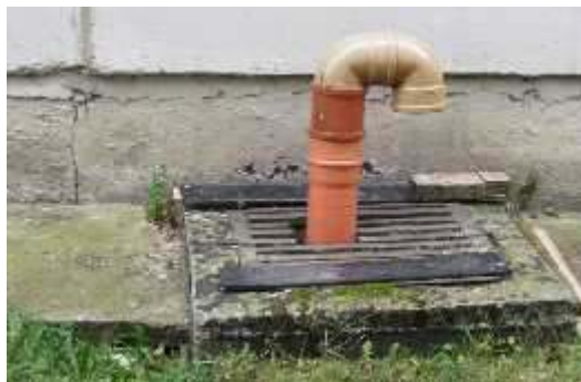
4.1.7.att. Gaismas šahta ar pagraba ventilācijas izvadu. Šahtas siena apaugusi ar sūnu.
