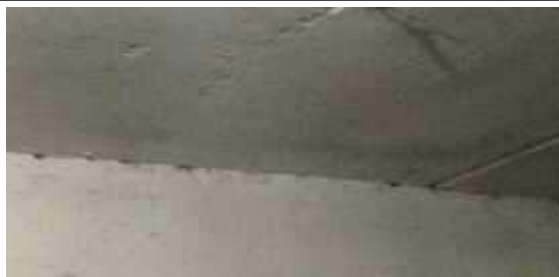
4.6.5.att. Virsmas izdrupumi pagraba pārseguma panelim.
