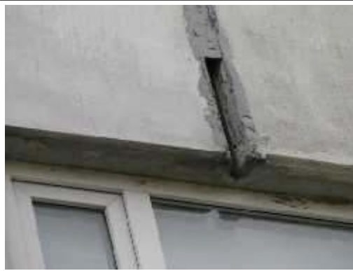
4.2.9.att. Izdrupusi panelu saduršuve.
