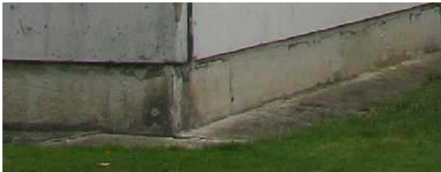
4.1.5.att. Apmale saplaisājusī un deformējusies pie ēkas DR stūra.
