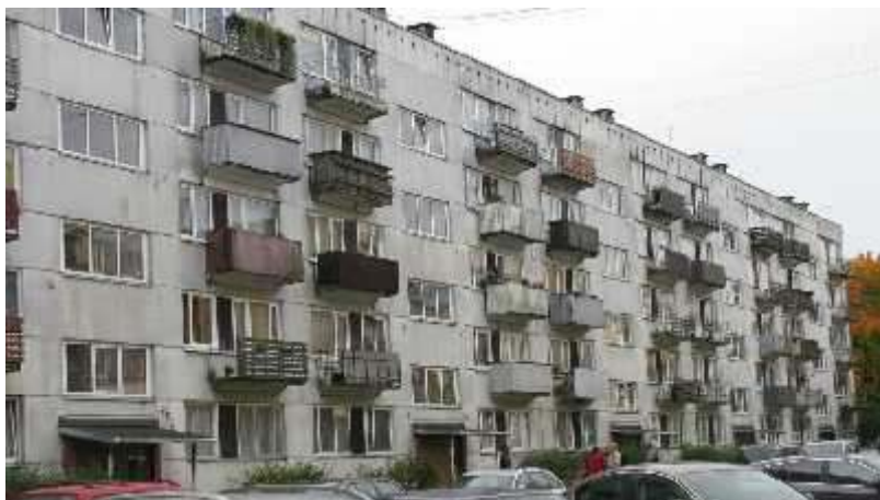
4.2.1.att. Ēkas ZA sānu fasādes fragmenta skats no A gala.
