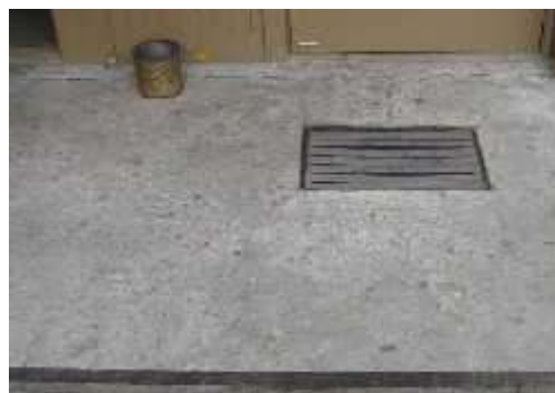
4.9.5.att. Monolīta betona lieveņi.
