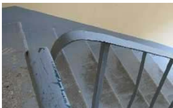
4.10.1.att. Pakāpieni un laukuma virsmai nodilusi apdare – krāsojums.
