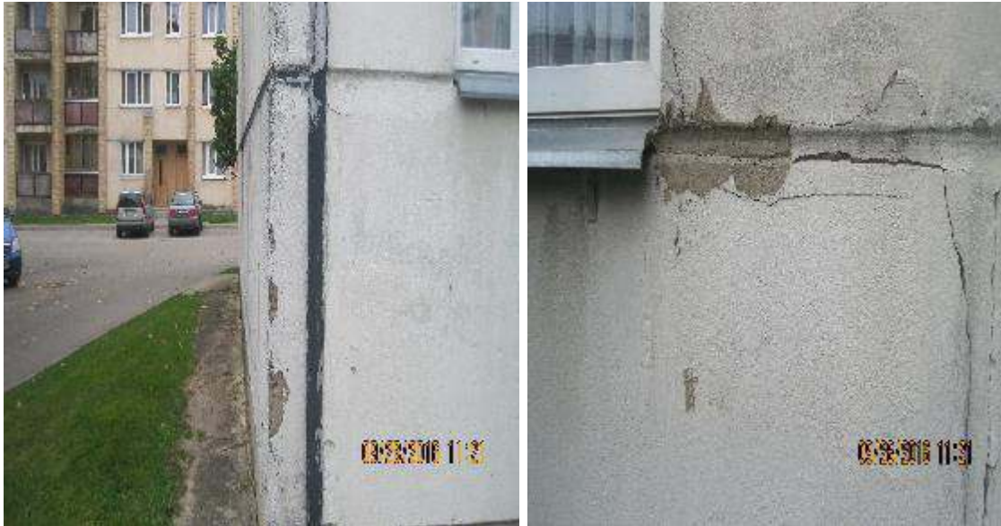
Nepieciešama ēkas sienu sanācija, paneļu šuvju aizpildīšana pirms siltināšana.
