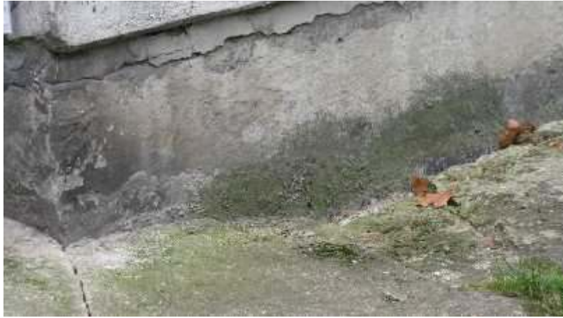
4.1.4.att. Apmale deformējusies, cokols un apmale ar melniem un zaļiem mitruma radītiem plankumiem.
