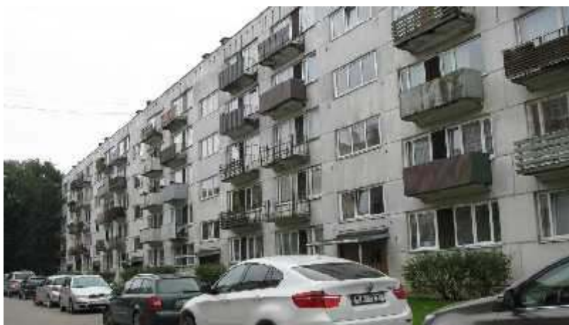
4.2.2.att. Ēkas ZA sānu fasādes fragmenta skats no R gala.
