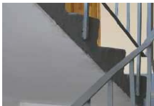
4.10.2.att. Lenterī bez plastmasas seguma.
