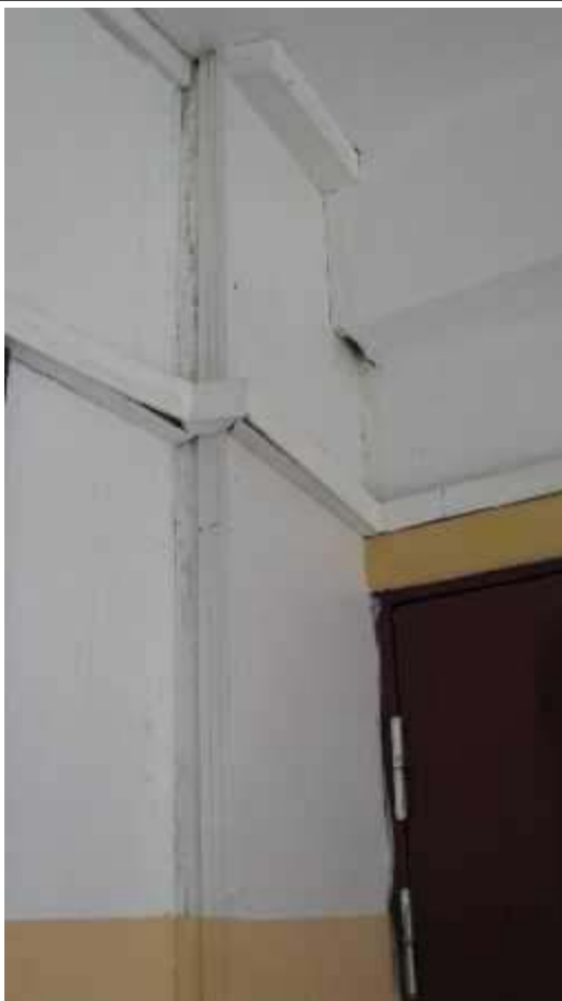
4.8.6.att. Siena un iekšējās nokrišņu notekcaurules apšuvums ar mitruma plankumiem.
