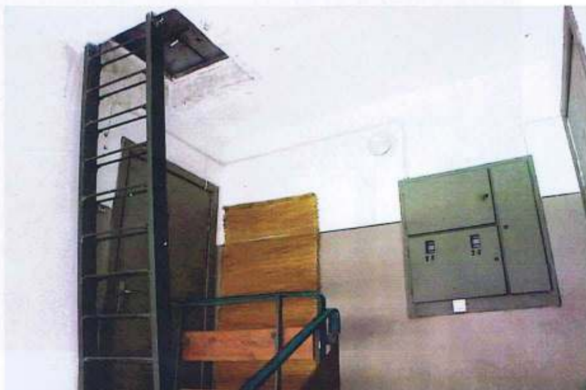
F-35; Kāpņu fragments ar izeju uz jumta. E bloks
