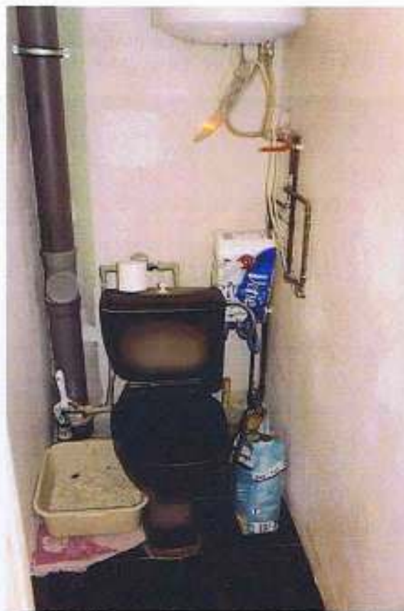
F-37; WC mezgls dzīvoklī Nr.5. A bloks
