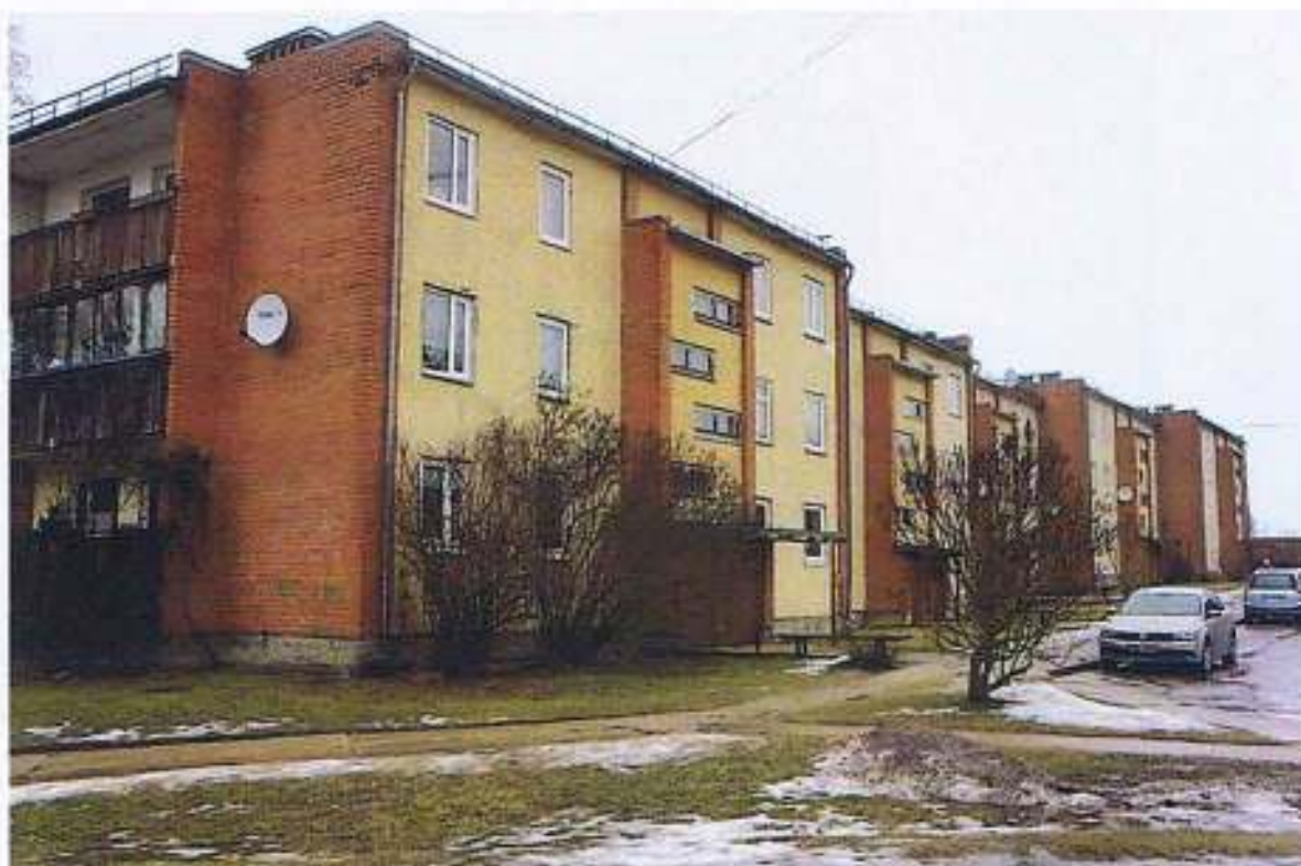
F-3; Ēkas (AD) fasādes fragments.
