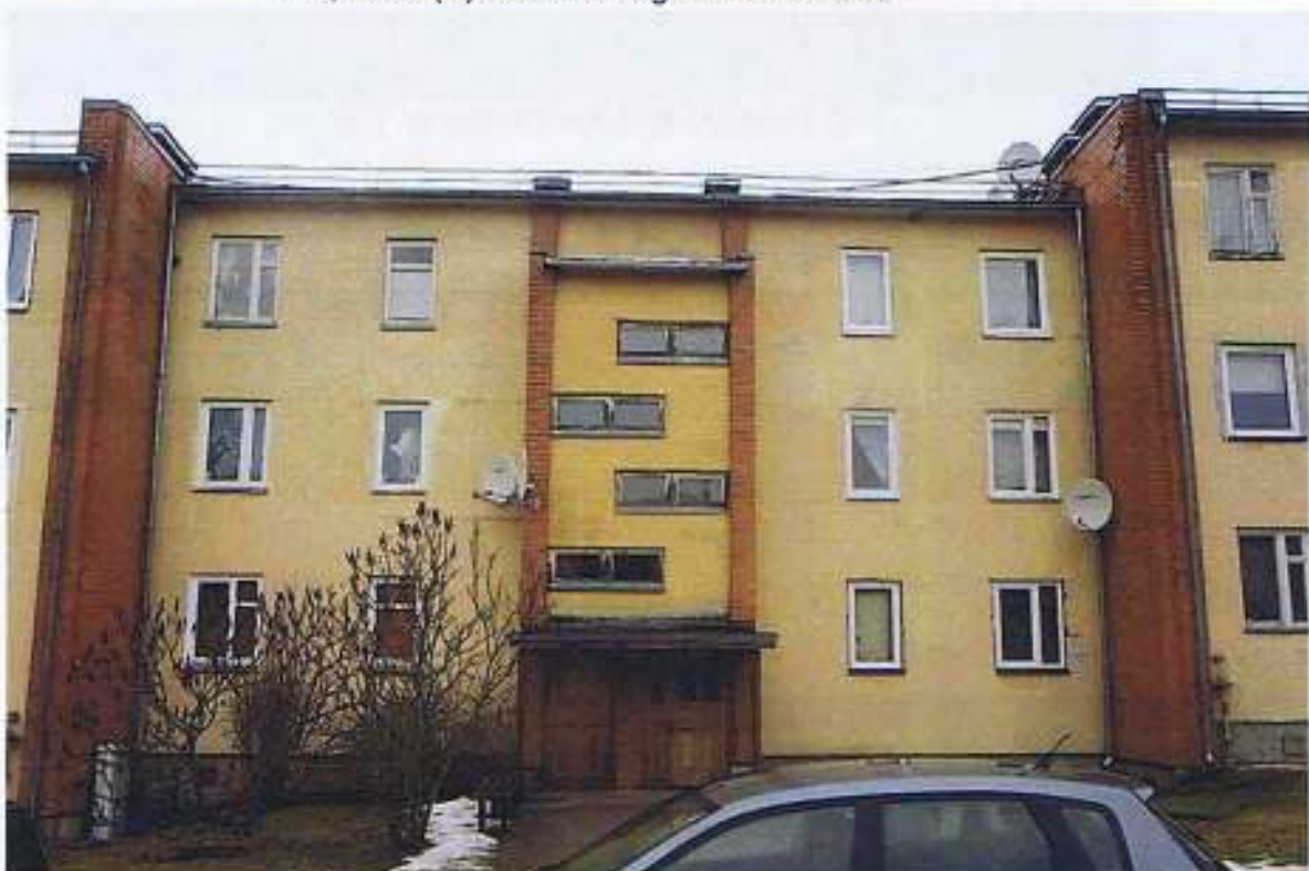
F-6; Ēkas (A) fasādes fragments. C bloks
