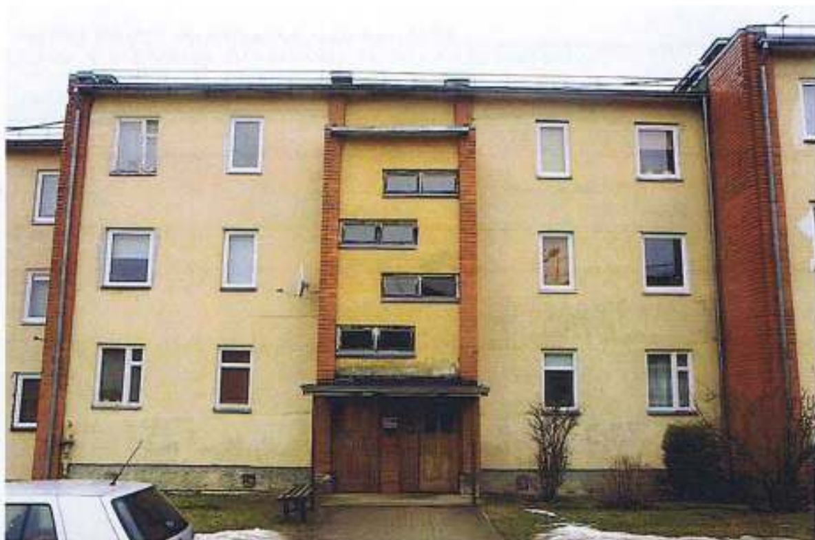
F-5; Ēkas (A) fasādes fragments. D bloks
