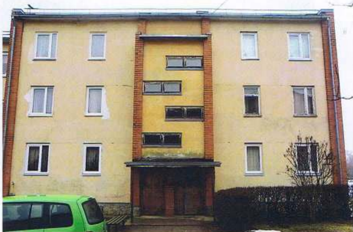
F-4; Ēkas (A) fasādes fragments. E bloks
