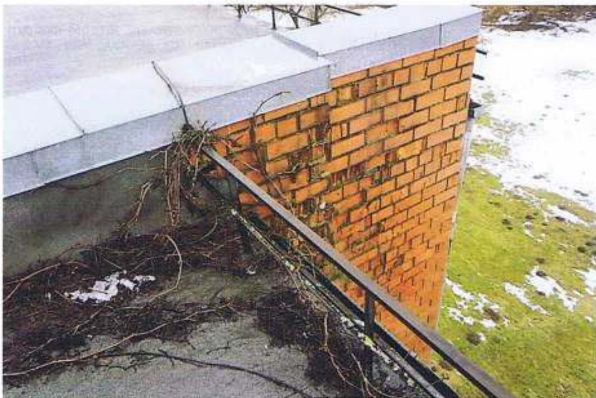
F-49; Jumta fragments ar bojātiem ķieģeļiem. E bloks
