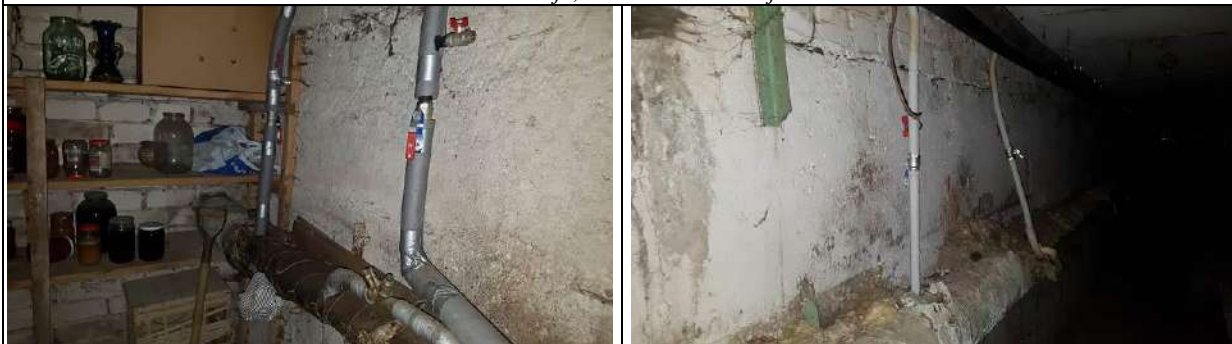
11.att. Apkures guļvadi pamatā ir izolēti ar veco siltumizolācijas slāni. Stāvvadi pagrabā ir izolēti ar pretkondensāta izolāciju vai tiem vispār nav nekāds siltumizolācijas.
