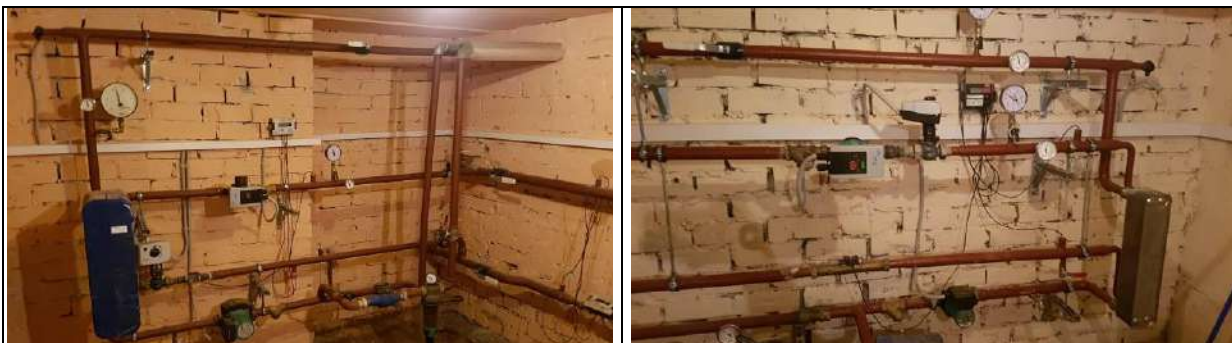
8.att. Ēkā uzstādīti divi neatkarīgā pieslēguma tipa siltummezgli, kuros tiek uzsildīts ēkas apkures loka siltumnesējs, kā arī tiek sagatavots karstais ūdens. Ēkas siltummezgli tika atjaunoti 2018. gada vasarā un to cauruļvadus ir nepieciešams siltināt.
