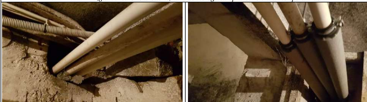
10.att. Karstā ūdens apgādes cauruļvadi vietām siltināti ar pretkondensāta izolācijas materiālu vai arī tiem nav uzstādīta siltumizolācija, vai arī tā ir novecojusi.
