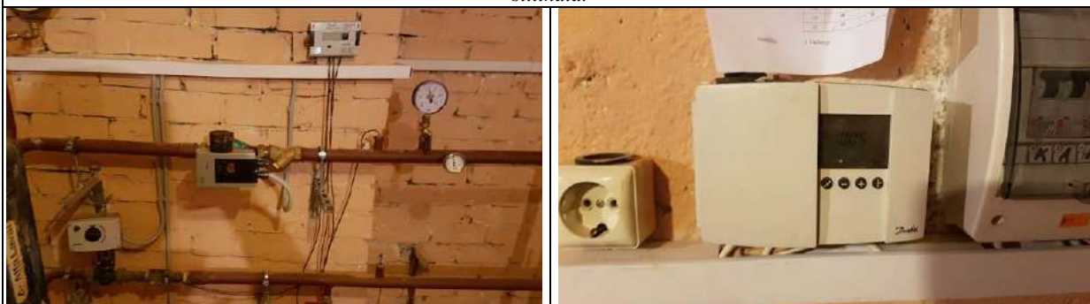
9.att. Katrā siltummezglā ir uzstādīts kopējais un atsevišķi karstā ūdens sagatavošanas siltumenerģijas skaitītājs. Tāpat arī katram siltummezglam ir savs kontrolieris, kurā tiek ieregulēti apkures režīmi un temperatūras.
